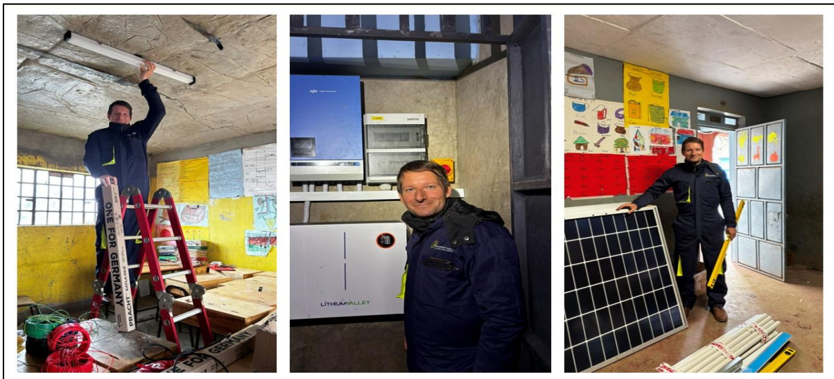
Sven zu Besuch auf einer MIK-ESS Baustelle (Slum-Schule)
