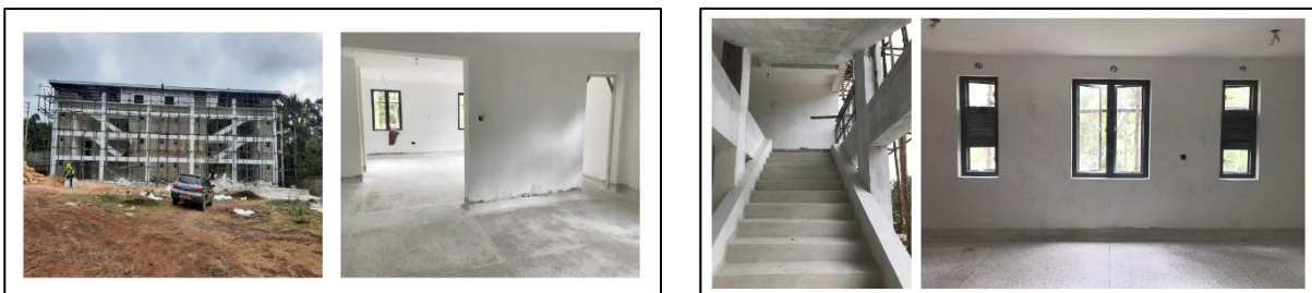
MIK-ESS Baustelle (Waisenhaus für Straßenkinder)
