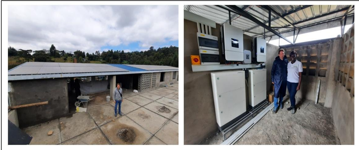
Besuch von Sven und B4T-CEO Irene auf einer M-K-ESS Baustelle (Waisenhaus für Straßenkinder)
